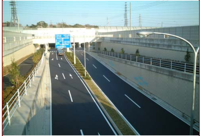
道路擁壁(アンダーパスアプローチ区間)
