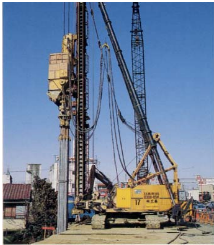
施工(中掘圧入工法)
