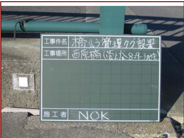
初期導入作業 (近距離無線通信タグ設置完了)
