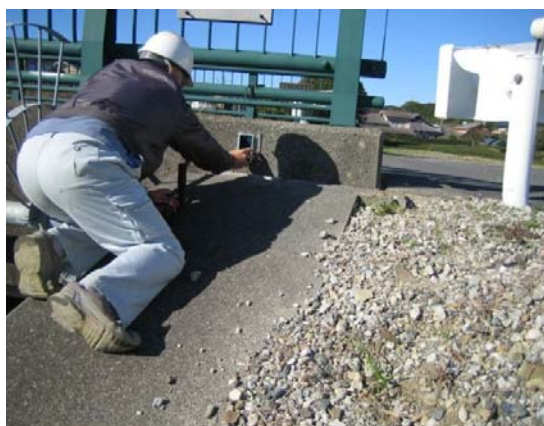
送受信確認(近距離無線通信タグとモバイル端末の動作確認)
