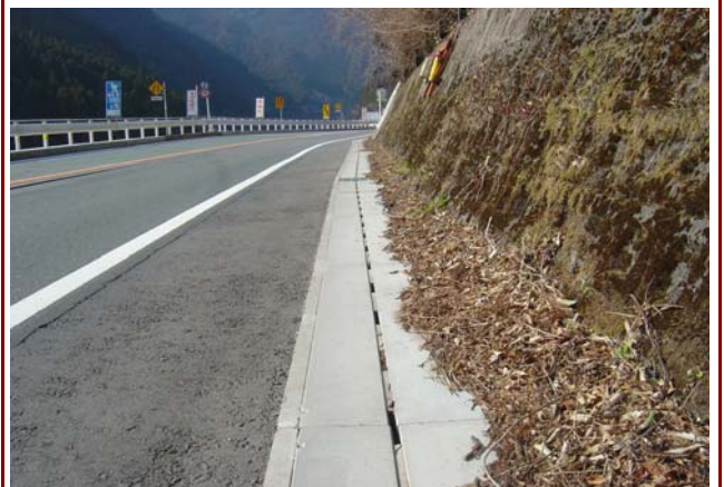
浜松市役所:R152側溝修繕工事
