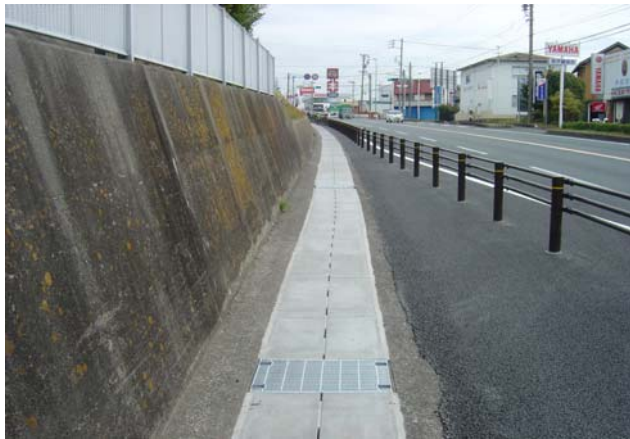
浜松河川:平成20年度浜松管内東部地区道路整備工事
