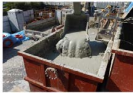
①泥土発生
