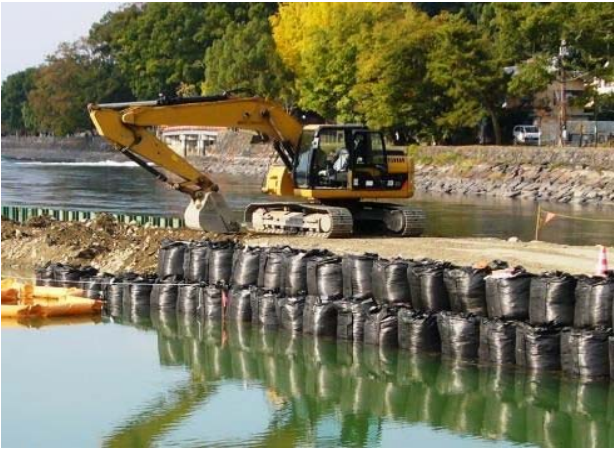
H27年京都府宇治川河川改修工事
