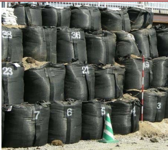
道路工事 土留め工使用例
