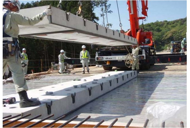
②底版設置
