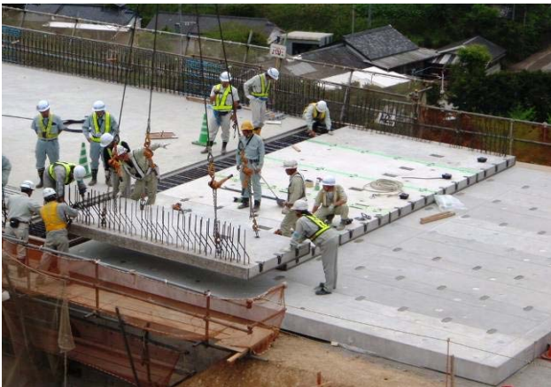
③延長床版設置
