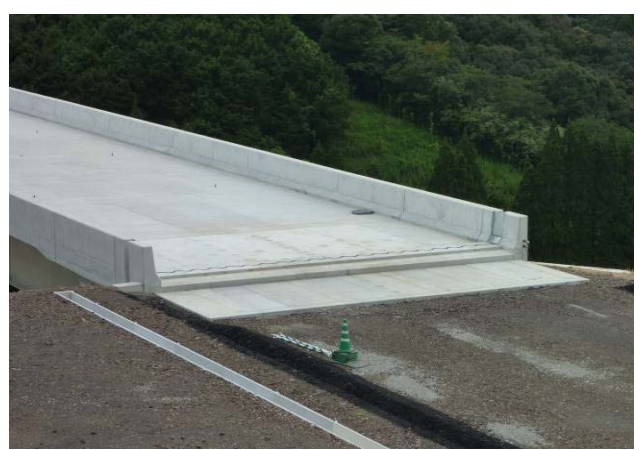
⑥延長床版施工完了
