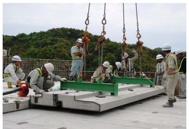
④着脱式床版(伸縮装置)設置
