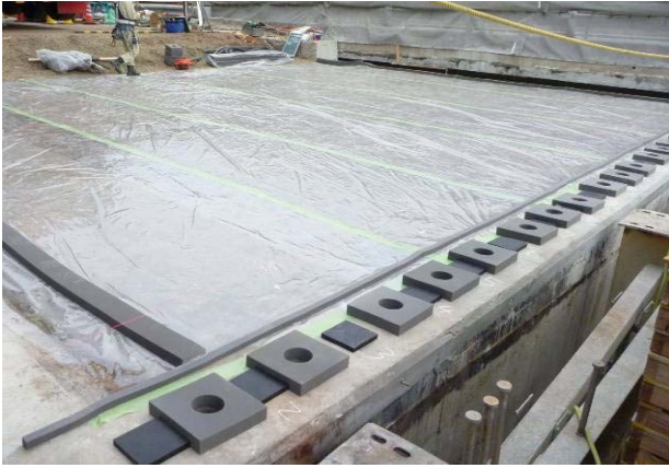
①ビニルシート敷設
