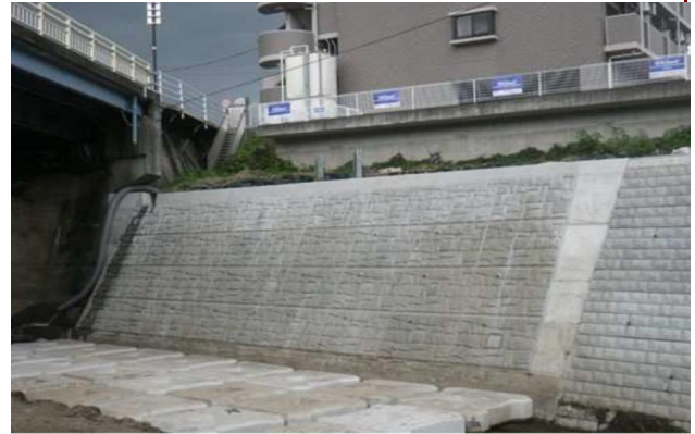
黄瀬川本宿護岸災害復旧 完成写真
