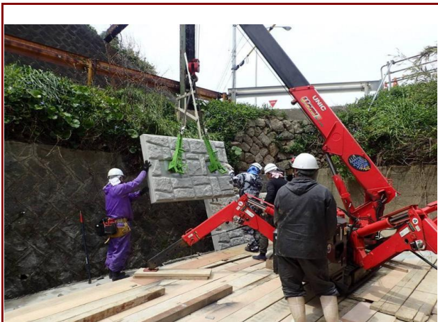
木与防災田部地区改良 作業状況
