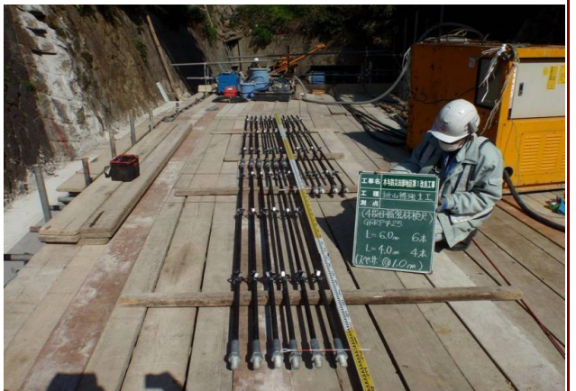
木与防災田部地区改良 GFRPロット
