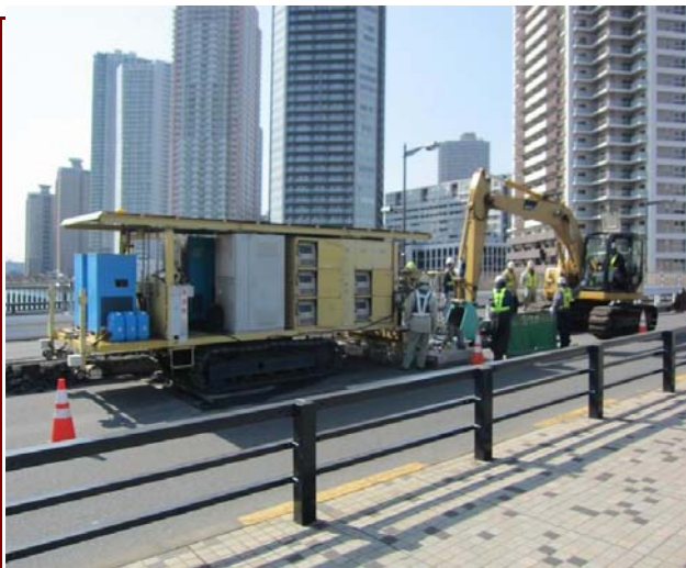
騒音の反響しやすい高層建築街での施工
