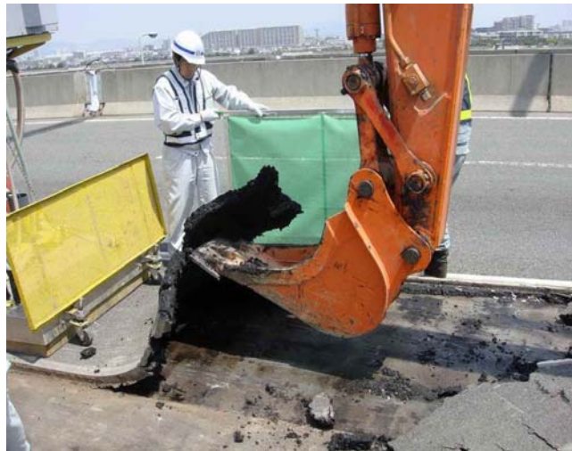
アスファルト舗装撤去状況
