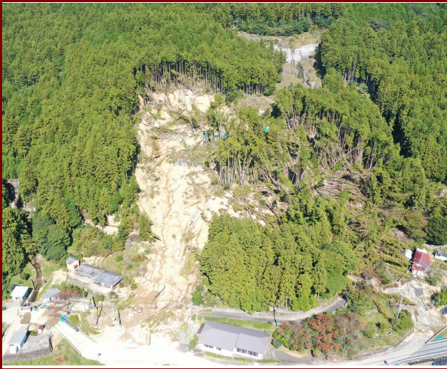
2020年10月台風14号により山腹崩壊発生
