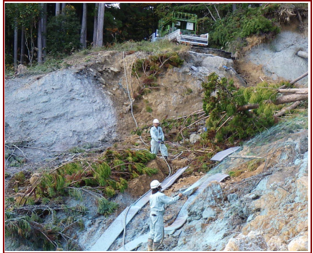
同年11月ポリソイル緑化工による応急工事
