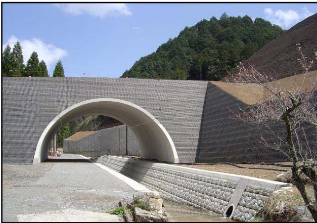
施工事例-1 (カルバートとの組み合わせ)
