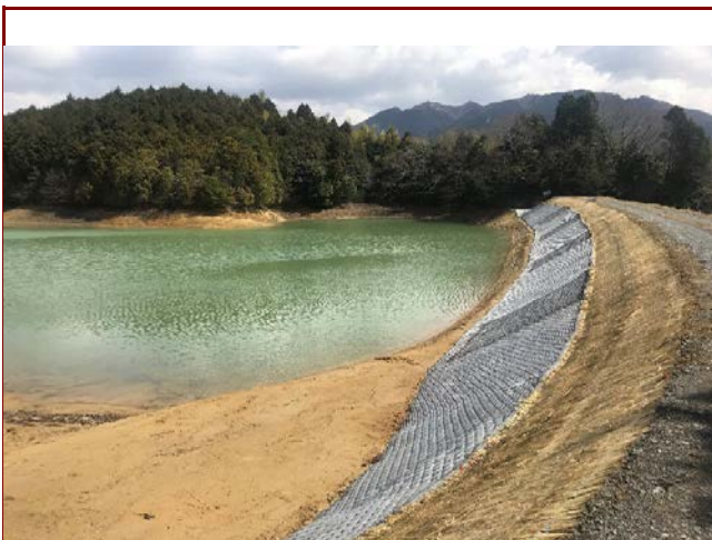
樋之谷池護岸工事(三重県)
