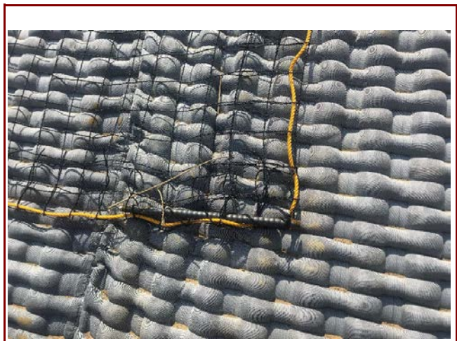
樋之谷池護岸工事(三重県)
