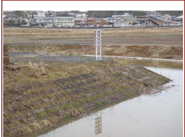
伊豆沼2工区地区区画整理(7)外工事(宮城県)
