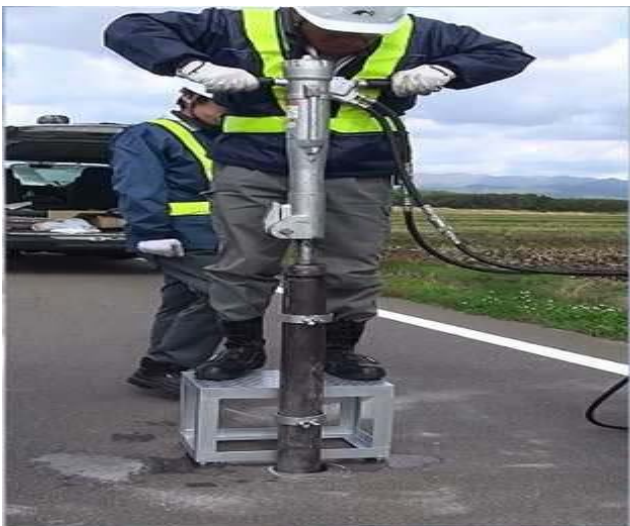
小口径ボーリング
