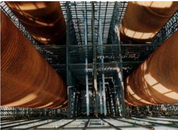
施工状況2.jpg
