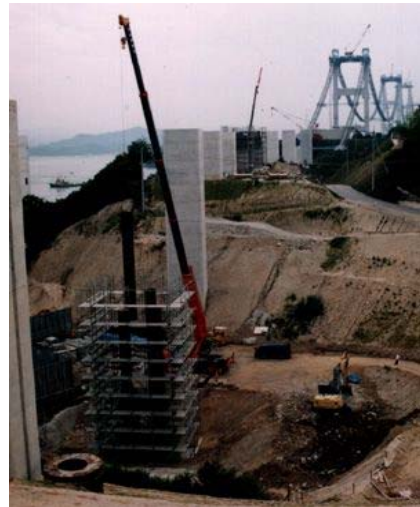
施工状況1.jpg
