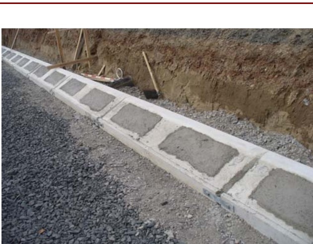
施工完了(間詰めコンクリート打設後)
