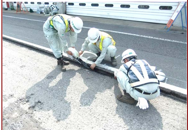
施工状況 (切削断面用)
