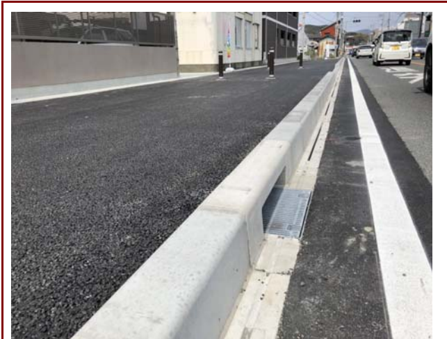
京都国道事務所:国道9号亀岡他歩道整備工事
