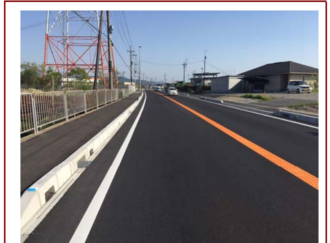
京都国道事務所 国道24号山城町北河原地区歩道整備工事
