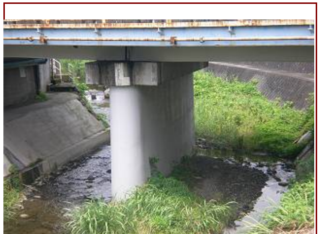
静岡土木事務所 和瀬川橋(清水区由比)
