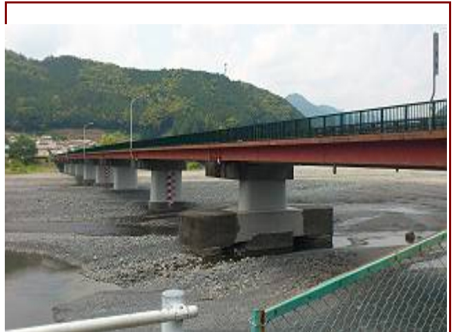
島田土木事務所 下泉橋(大井川)
