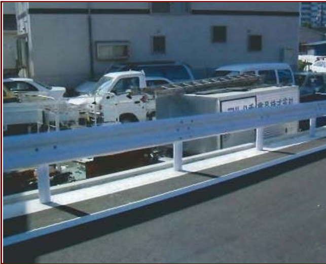
施工実績写真(静岡市)
