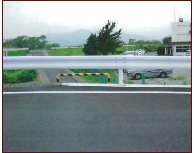
施工実績写真(島田市)
