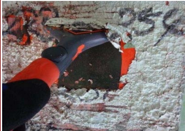
剥離作業(刃付スクレーパー使用)
