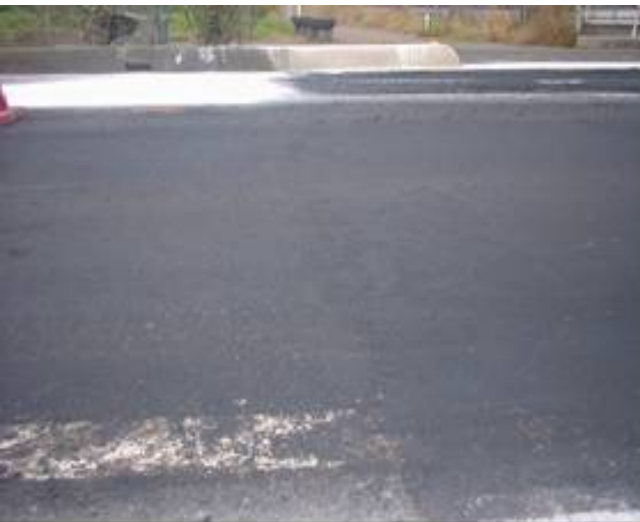
転圧後の路面状況
