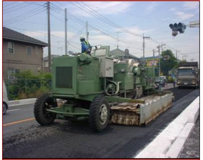
ヒータ車による加熱状況
