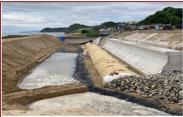
鳥取河川国道事務所 国道9号浜村地区災害復旧工事
