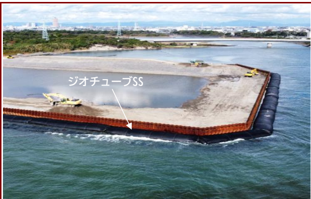
静岡県 馬込川 地震・高潮対策工事(仮締切工)
