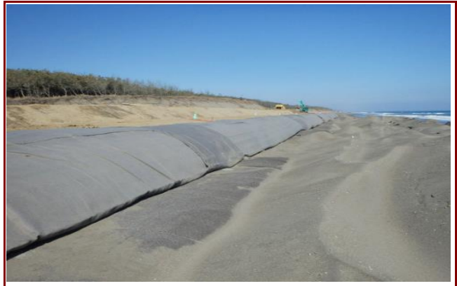
宮崎河川国道事務所 宮崎海岸埋設護岸等工事
