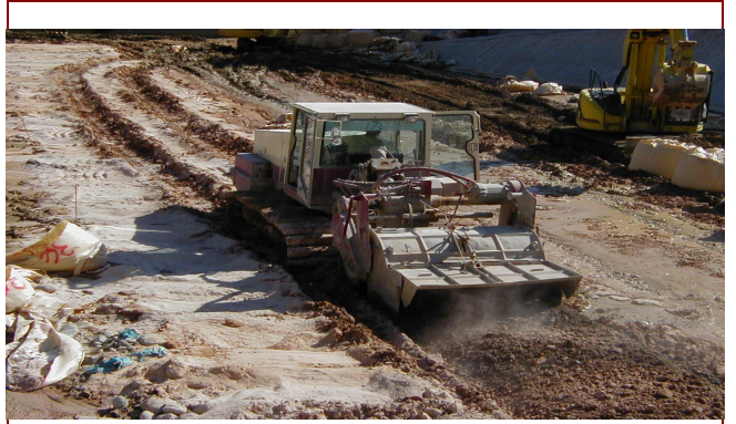
空港整備工事(S4調節池)
