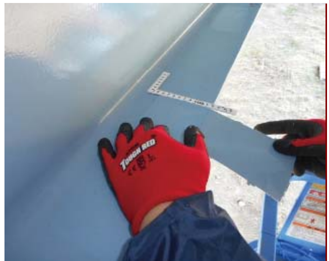
③ RACタッチ貼り付け
