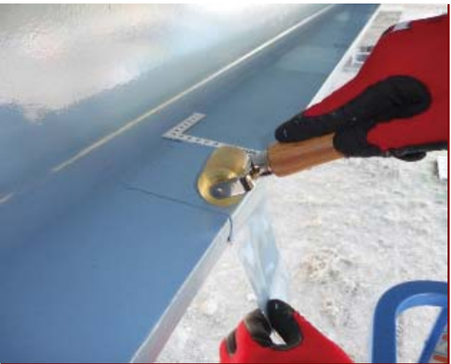
④ RACタッチ圧着状況
