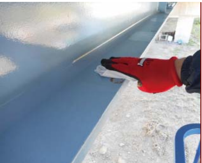
② 下地処理・清掃工
