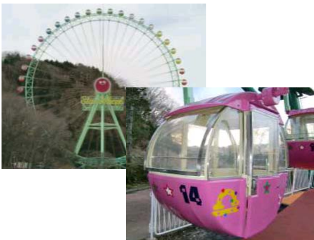
東京サマーランド大観覧車塗替え鉄部塗装工事
