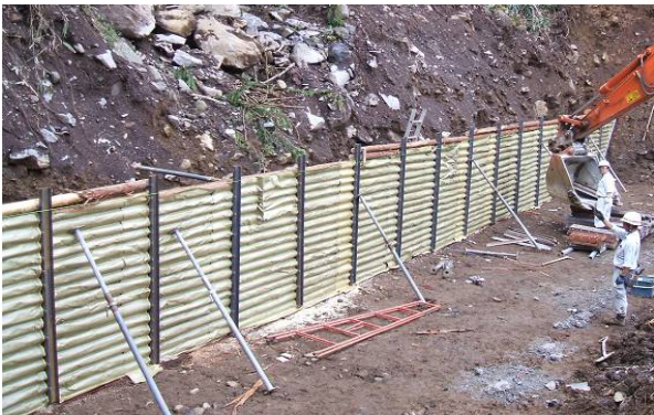
上流側(1段目) 漏れ防止材貼付け完了
