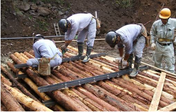
丸太を溝型鋼・専用金具にて組立 組立状況
