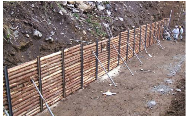
上流側(1段目) 型枠設置完了
