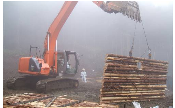
バックホウ(クレーン仕様) 型枠吊込み状況
