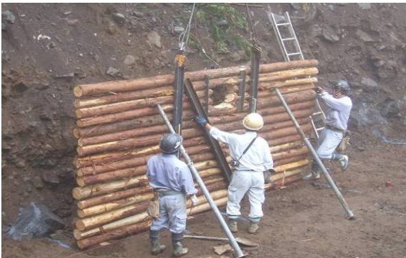
水抜き穴を基準に1枚目を設置 型枠設置状況
