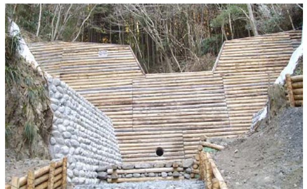
下流側(皮むき丸太使用) 完成
