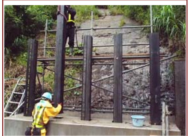
鋼管柱建込み状況
