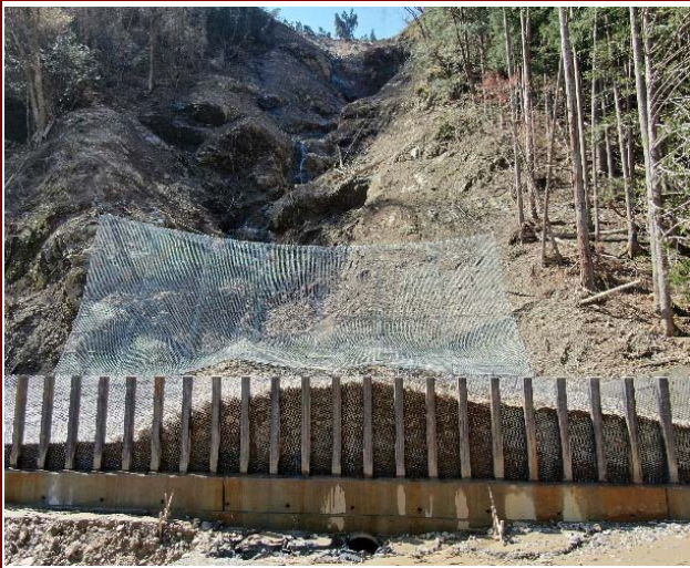
土砂捕捉状況
