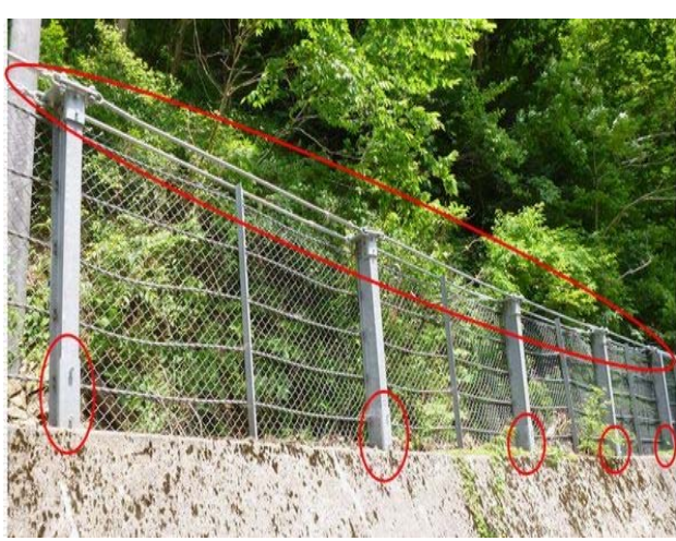
試験施工(富山県が管理する道路)
