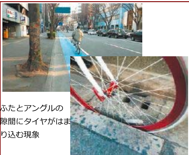
従来工法: 自転車タイヤのはまり込み
