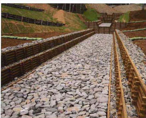
施工事例:木製枠護岸工(静岡署:小山地区)
