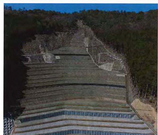
施工事例:木製枠筋工(和歌山署:下モ谷)
