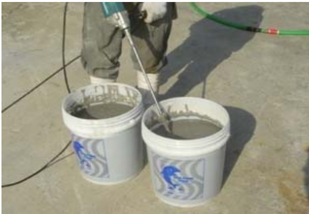
プライムと希釈水をハンドミキサーで練り混ぜる
