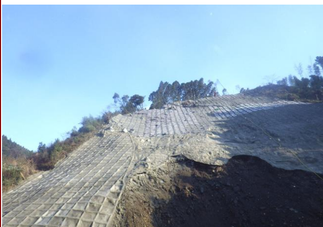
大分県 熊本地震災害復旧工事現場
