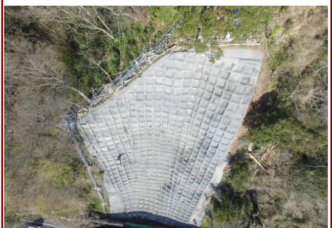
静岡県 熱海土木事務所工事現場-4
