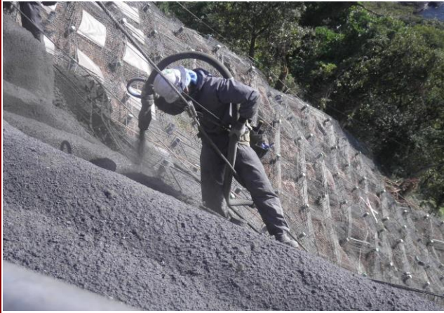
静岡県 熱海土木事務所工事現場-1
