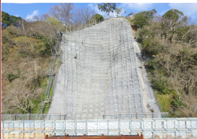
静岡県 熱海土木事務所工事現場-3
