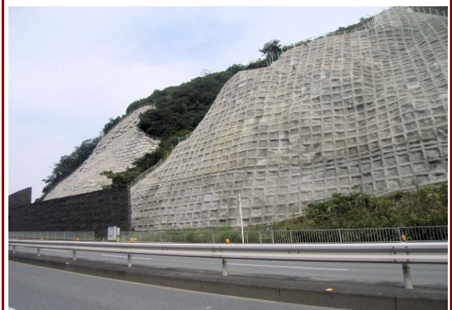
和歌山県 道路防災工事現場
