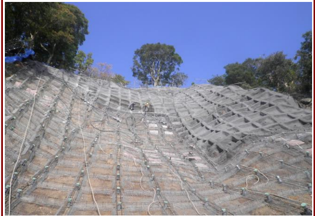
静岡県 熱海土木事務所工事現場-2
