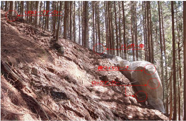
巨大岩塊固定工法概要図
