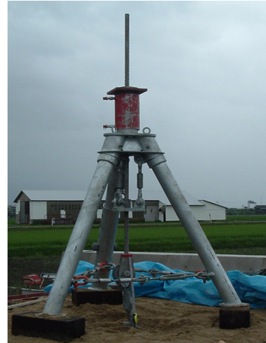
UBロープアンカー引抜試験状況
