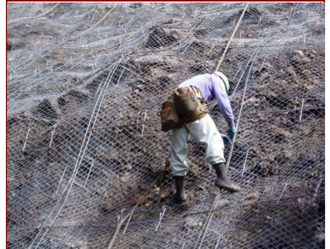
配筋・組立工設置工
