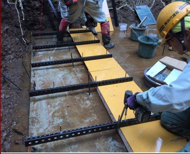
1 カチオンフレーム(合板)組立て
