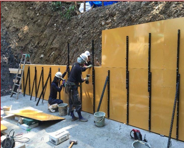
3 カチオンフレーム(合板)組立て
