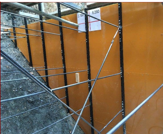
5 カチオンフレーム(合板)溶接固定
