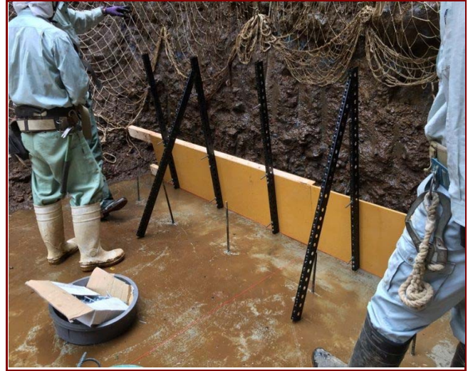
2 カチオンフレーム(合板)組立て
