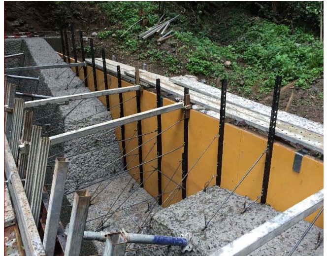
4 カチオンフレーム(合板)溶接固定
