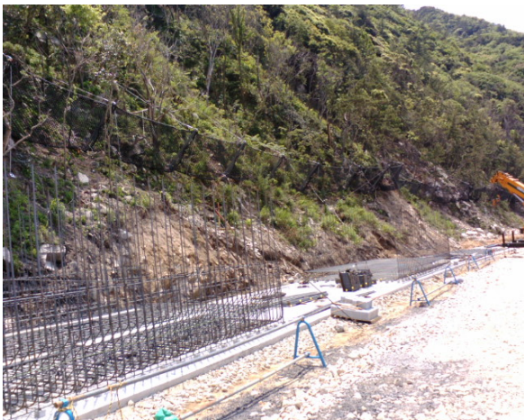
日本原子力発電所(株) 敦賀発電所施工事例
