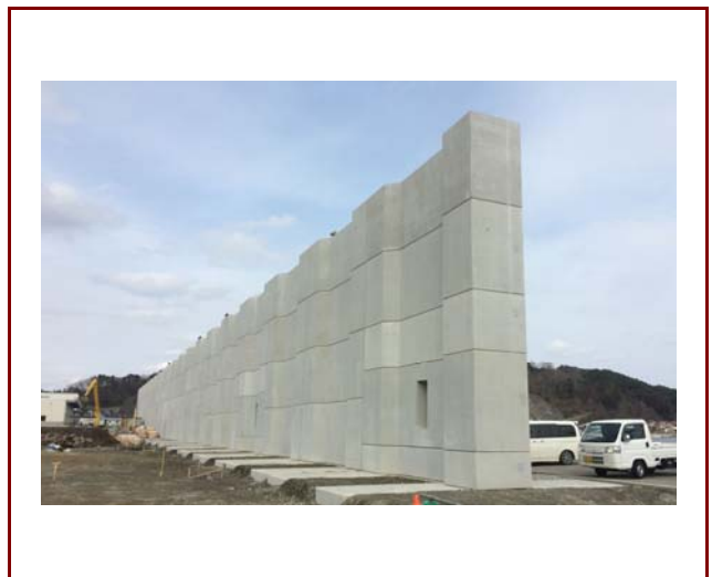
施工実績①
