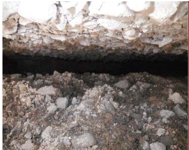
踏掛版下の空洞と地盤の緩み
