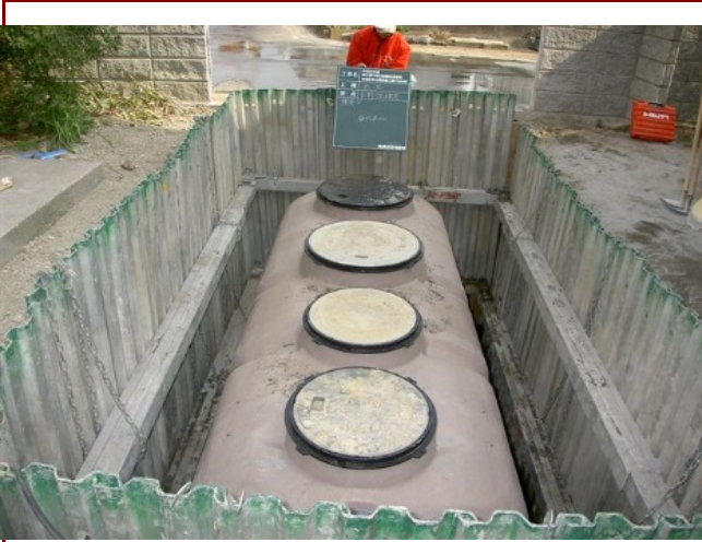
浄化槽設置工事
