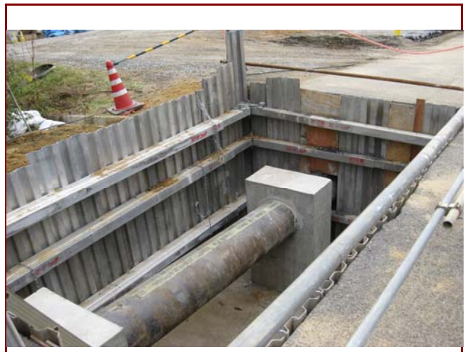
水道管改良工事
