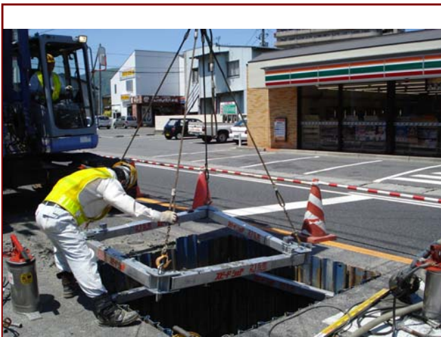
下水道マンホール設置工事
