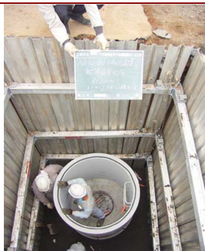
下水道マンホール設置工事
