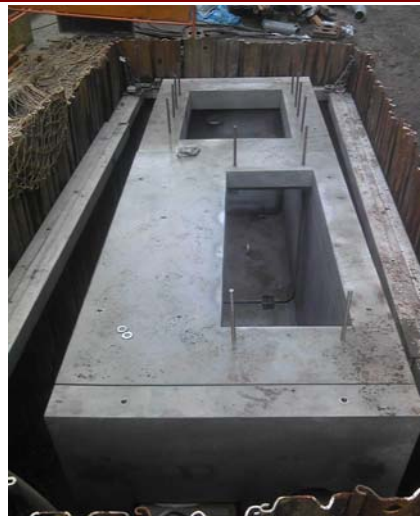
電線共同溝工事
