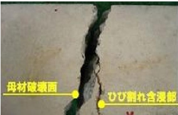
供試体破壊状況 (母材破壊)
