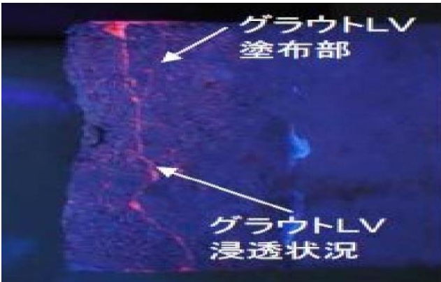
施工後の樹脂充填状況 (表面部)
