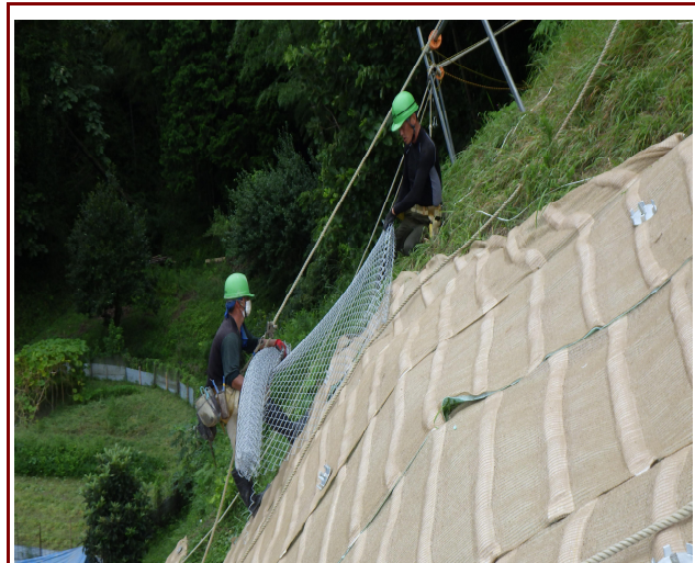
施工時(金網設置時)
