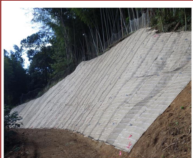
施工後の状況(施工完了後)
