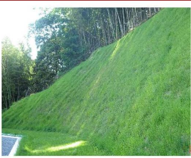
施工後の状況(施工後6か月)
