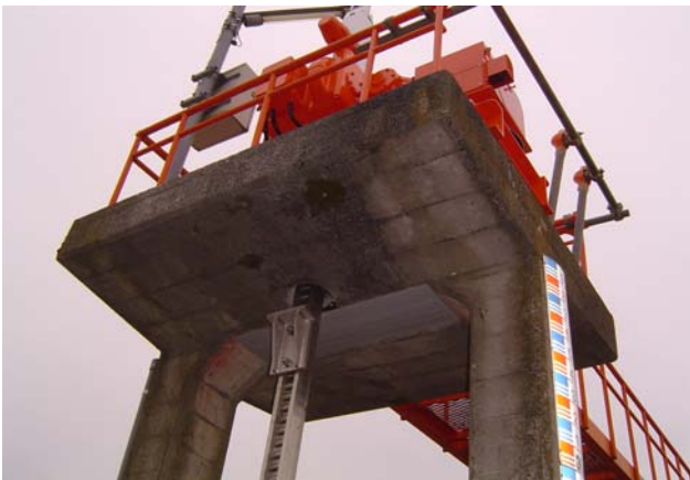
鶴川沙流川維持工事の内管理施設設置
