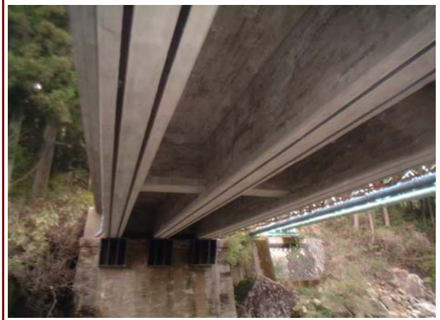
平成17年度県単道路特殊改良工事
