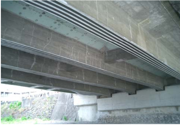
24号嗟峨谷橋 耐震補強工事
