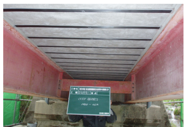
平成19年度 地方道路整備臨時交付金事業 中分中央線(中分橋)
