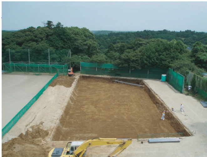
同左 (貯留・浸透層の床付け状況)
