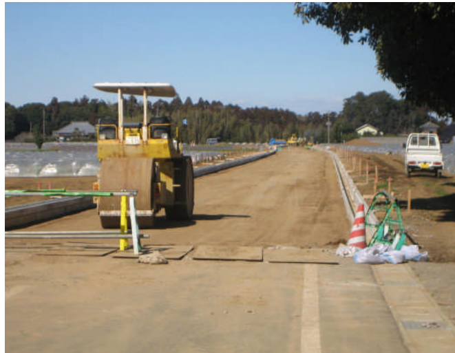
東総台地広域営農団地農道整備工事 (道路排水施設下部に雨水流出抑制施設を設置した整備状況)
