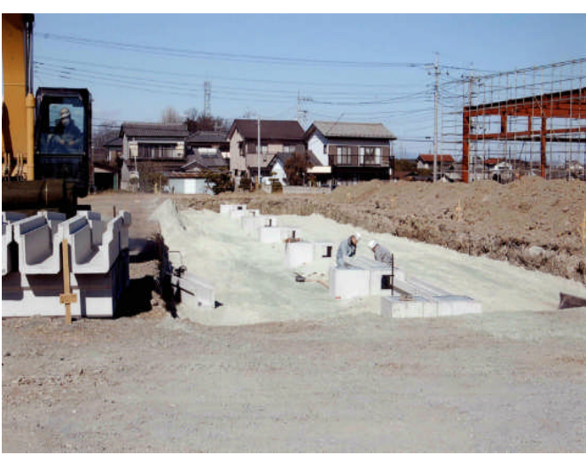
同左 (雨水集水樹とガラスカレット貯留浸透層の施工状況)
