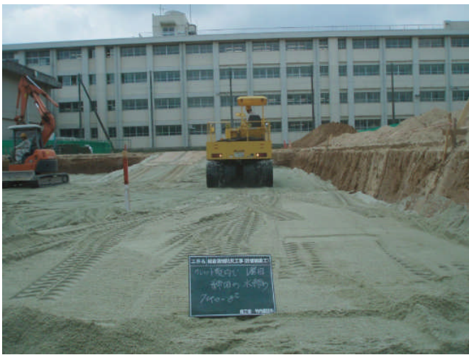
千葉県立佐倉高校テニスコート雨水貯留浸透施設工事 (ガラスカレット敷均し・転圧状況)
