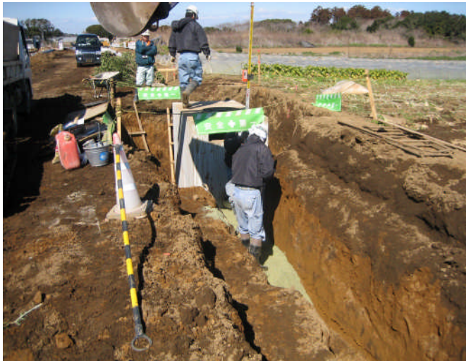
同左 (道路排水施設下部に投入中のガラスカレット材)
