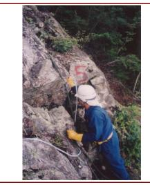
浮石除去状況 1 (亀裂にバルーン挿入)
