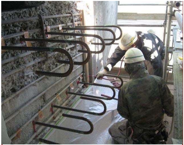
注入作業とアンカー鉄筋挿入
