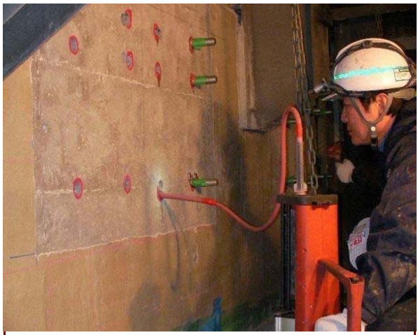
注入作業(横向き施工)
