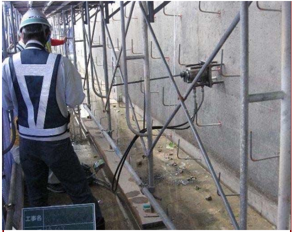
施工品質の確認(引張試験)
