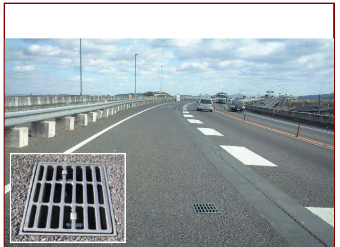
設置例(橋梁高架部・SSP)
