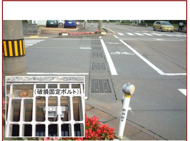
設置例(横断側溝・SP)
