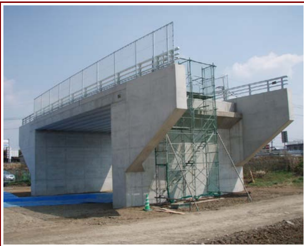
【完成写真】門形ラーメン構造
