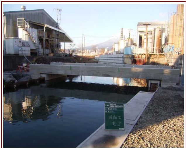
【完成写真】支保工・水切替不要(富士市)
