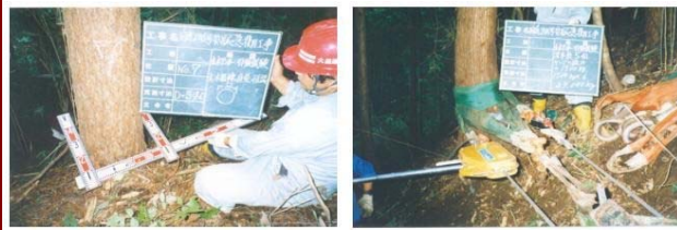
アンカー選定作業(生立木の根株測定) 生立木使用のアンカー引張試験作業
