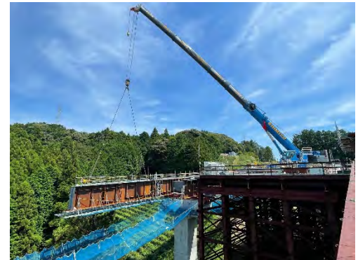
「真夏日の架設」 473号バイパス（島田市神谷城）
