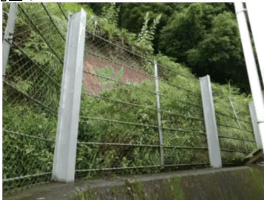
擁壁が住宅への土砂流入をストップ！ 「神島小室」(伊豆の国市神島) 災害発生日:7月3日
