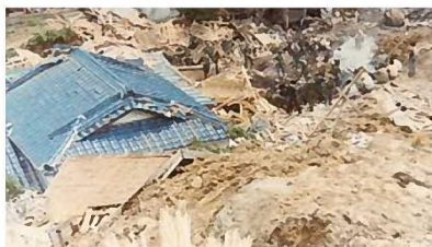
土砂に埋もれた住宅
